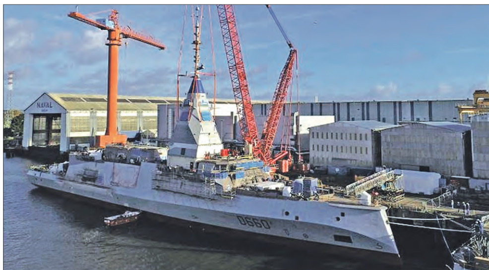
Установка панорамного модуля «Псим» на фрегат «Адмирал Ронарх»
